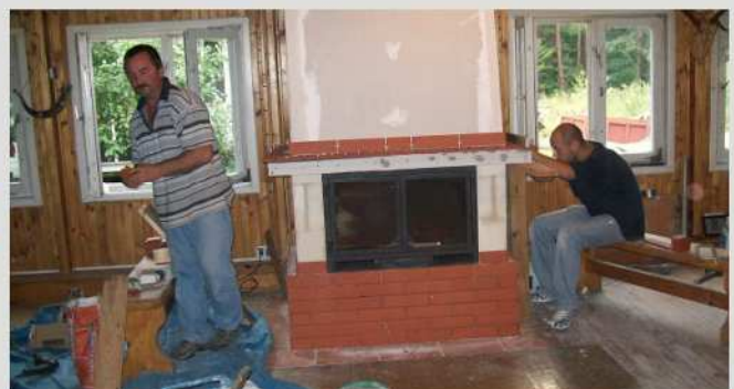
OSTATNIE PRACE PRZED SEZONEM GRZEWCZYM - OBUDOWA NOWEGO KOMINKA
